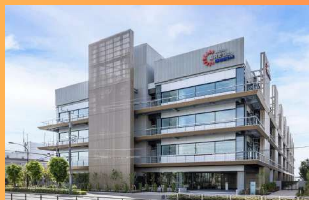
新木場にある三井リンクラボ新木場2
